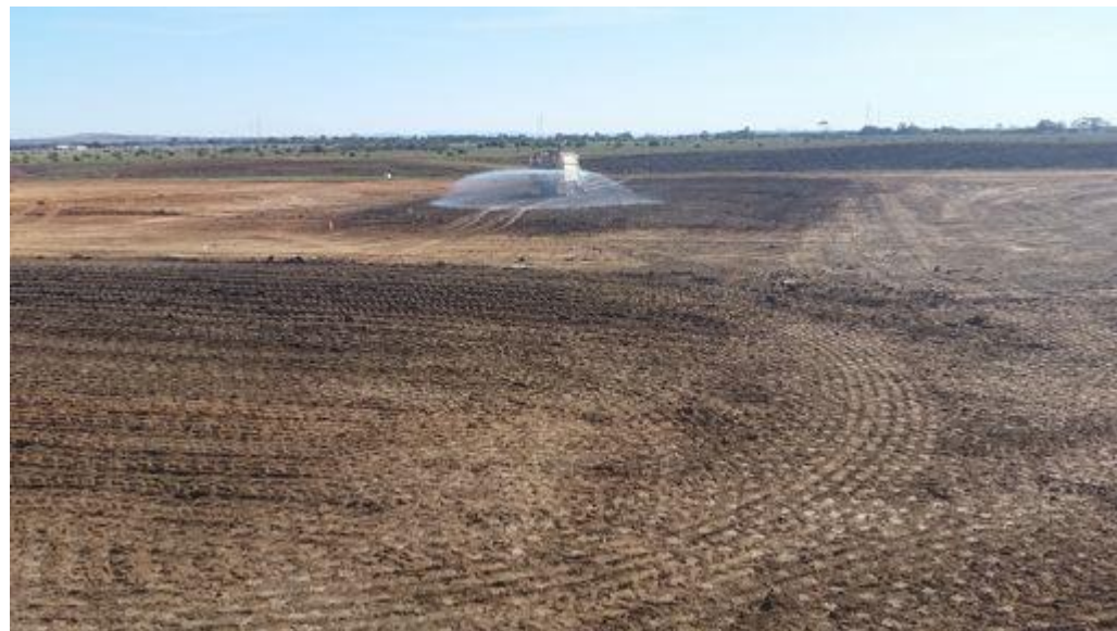
Water Cart moisturing layer 1
